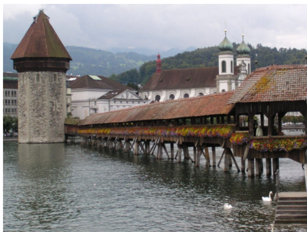
Die Kapellbrücke mit dem Wasserturm in Luzern
